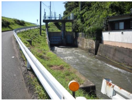
車尾地区戸上の米川取水口
