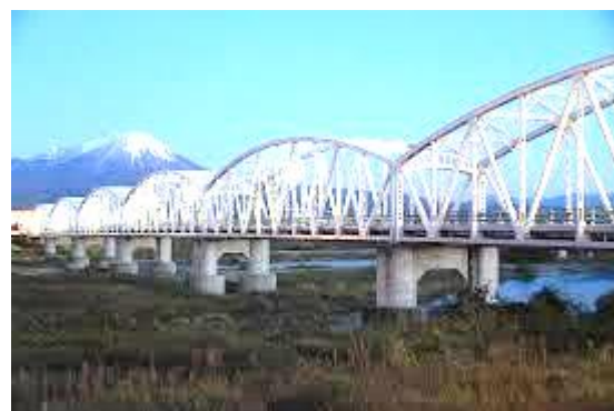
美しい6連曲弦トラス橋
