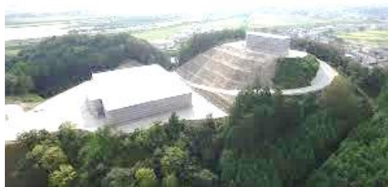
配水池の全景
