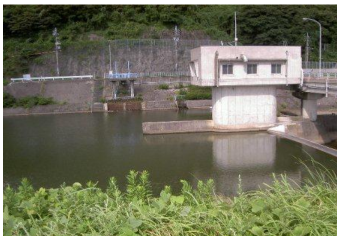
法勝寺川の取水口
